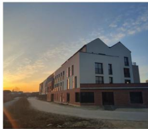
Travail de la brique en RDC
