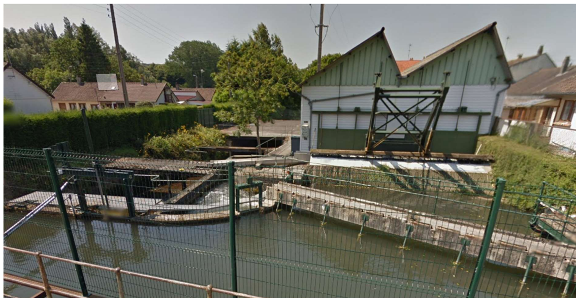
Figure 73 : Centrale micro-hydroélectrique installé sur la Bresle à Gamaches
