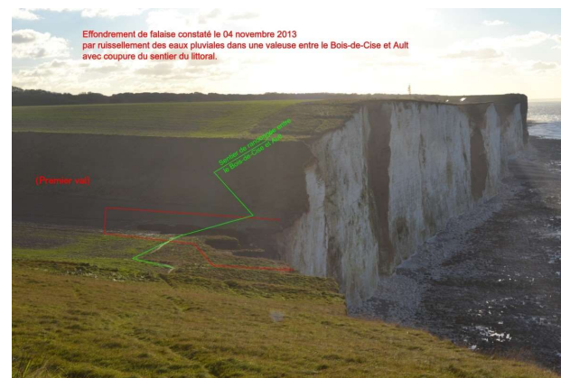
Figure 179 : effondrement du sentier de randonnée à Ault en novembre 2013
