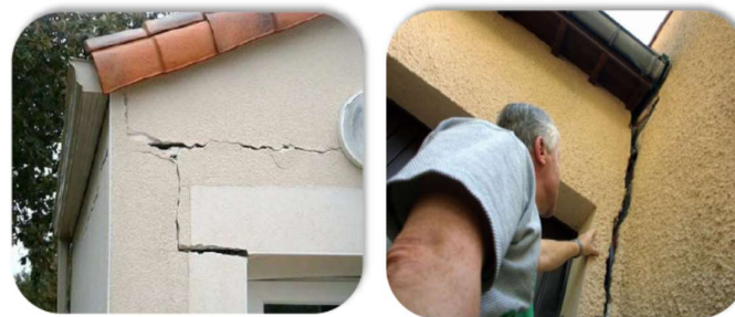
Figure 171 : exemple de dégâts causés par le retrait gonflement des argiles sur l'habitat - groupe SMA (gauche) et MEDD (droite)
