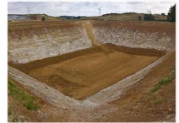
Une seconde barrière de sécurité, dite « active », vient en complément pour renforcer le dispositif. La pièce maîtresse de cette sécurité active est une « géomembrane » étanche surmontée d'un complexe drainant. Ce complexe permet la récupération des « lixiviats », c'est à dire des eaux de pluie entrées en contact avec le déchet.
