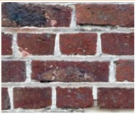
Appareillage « à la française ». Mise en œuvre de la brique qui superpose un lit de largeur et un lit de longueur de brique.
