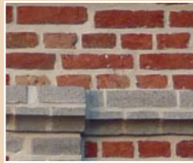
Brique du nord. Sa dimension est de 22 x 11 x 6 cm, sa forme et sa couleur varient selon les argiles qui la compose et la durée de cuisson artisanale.
