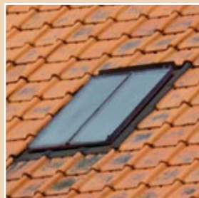
Lucarne «tabatière». Simple châssis de toit.
