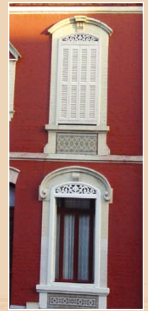
Persiennes repliables en tableau. Elles sont surmontées d'un lambrequin ajouré.
